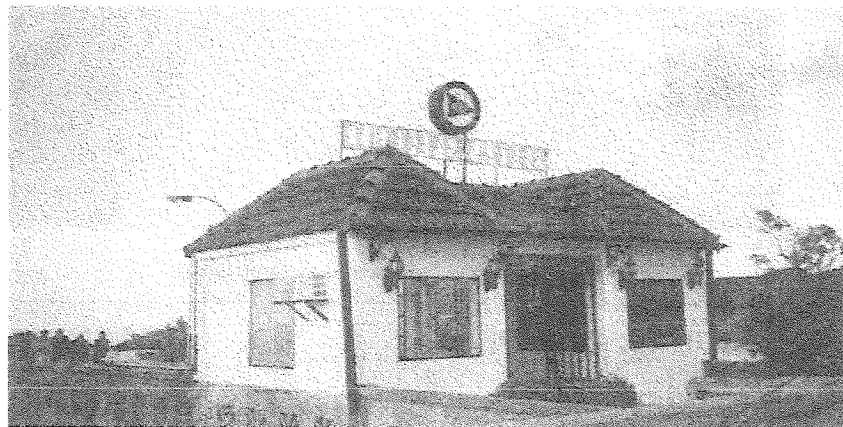
Vista actual de la obra terminada
