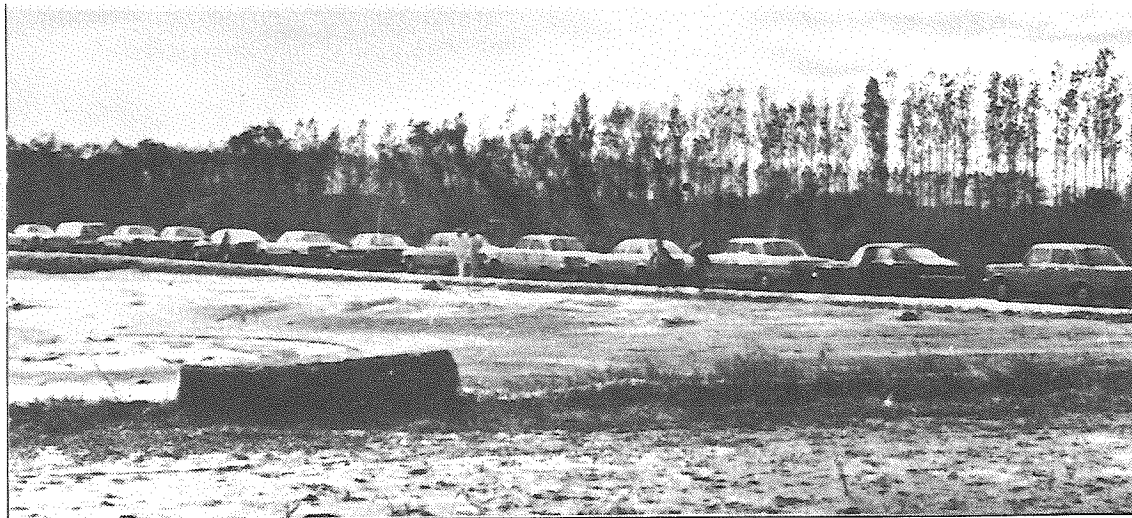
Vista parcial del camino Eliseo Fernández el día de su inauguración, que abarca además otra parte del relleno. Esta obra terminada llena un anhelo y los deseos de la C.D., de brindar a sus asociados una comodidad y un fácil acceso al Club que realmente faltaba.
